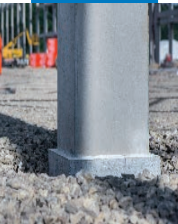
Grouteo de placas base
